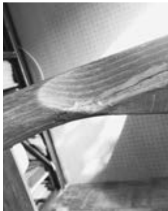
木目と直行して割れている部分に、接着剤がはみ出しているような雑な修復が施されていた
